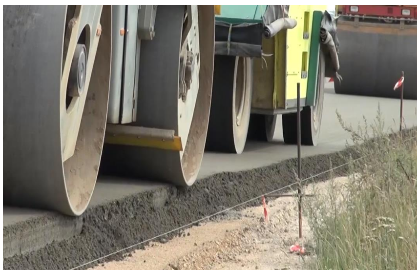
Fot. 4. Wałowanie nawierzchni walcami.
