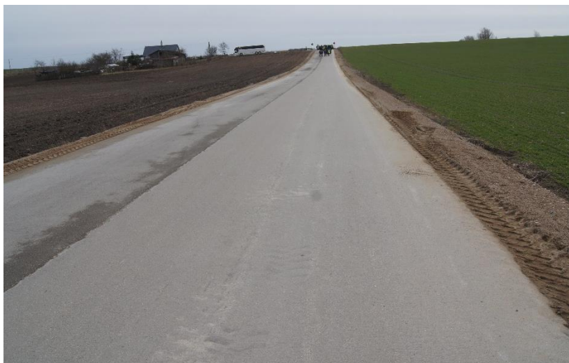
Fot. 2. Widok drogi ze zróżnicowaniem nawierzchni pasów: pas lewy z kruszyw łamanymi, pas prawy z grysów.
