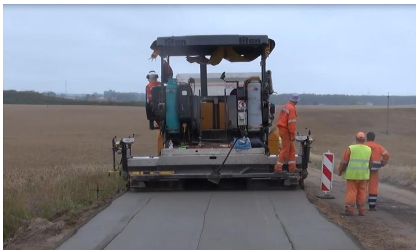
Fot. 3. Układanie nawierzchni rozścielaczem drogowym.
