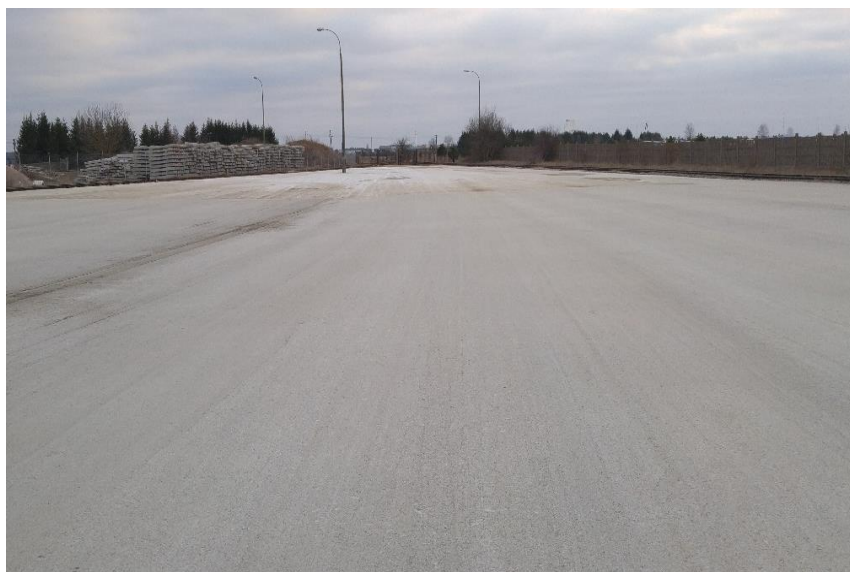
Fot. 1. Widok nawierzchni betonowej placu manewrowego z betonu wałowanego z rozstawem dylatacji przeciwskurczowych 50m.
